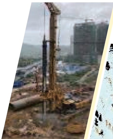
贵阳立交桥 抗滑桩项目
